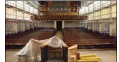
Gerüste im Kirchenraum, Foto: Hartmut Schäfer
