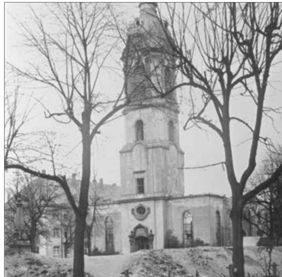
Die im Krieg zerstörte Karl-Friedrich-Gedächtniskirche erwartet 60 Jahre nach ihrem Wiederaufbau erneut einen zukunftsweisenden Umbau, Foto: Archiv Karl-Friedrich-Gemeinde
